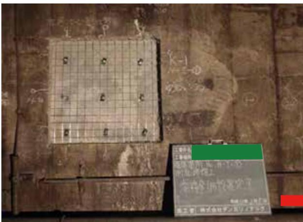
剥落防止補強金物設置状況
