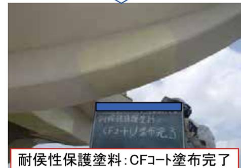
耐候性保護塗料:CFコート塗布完了
