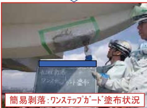
簡易剥落:ワンステップガード塗布状況
