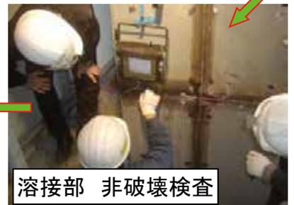
溶接部 非破壊検査
