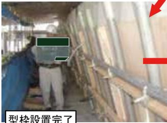
型枠設置完了
