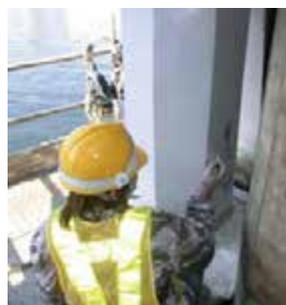
型枠脱型後、保護ライニング
